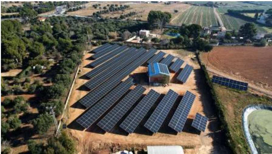
Planta fotovoltaica a la depuradora d'aigües residuals de Reus. ACN
