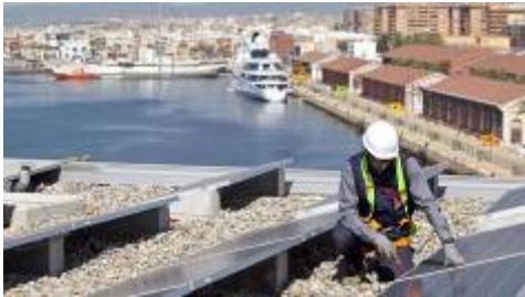
Un treballador instal·la plaques fotovoltaïques al port de Tarragona. / COMSA
