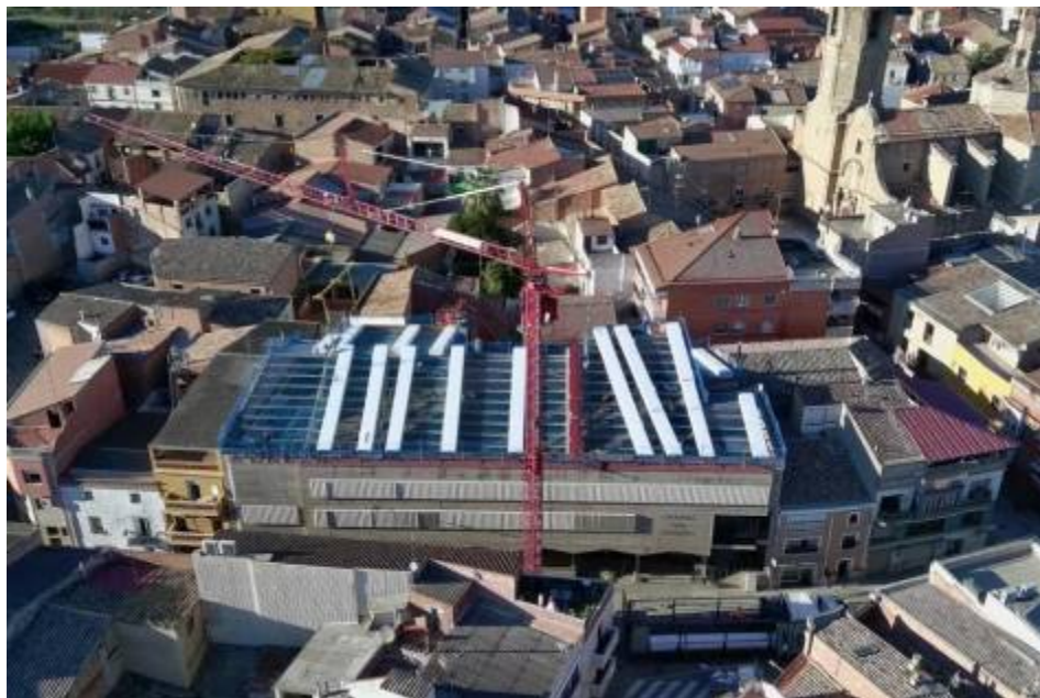
Les obres de reconstrucció de la teulada després de retirar l'amiant. - A.S.
