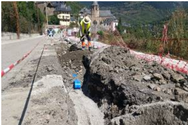
Imatge d'arxiu d'obres per substituir una canonada de fibrociment a Gausac el 2023. - AJUNTAMENT DE VIELHA
