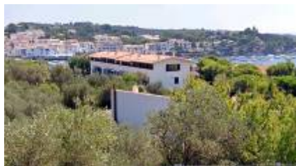
Pla general del sector del Doctor Bartomeus de Cadaqués, amb l'edifici que ja hi ha construït, i on ara s'hi volen aixecar 26 habitatges més / CEDIDA PER SOS COSTA BRAVA
