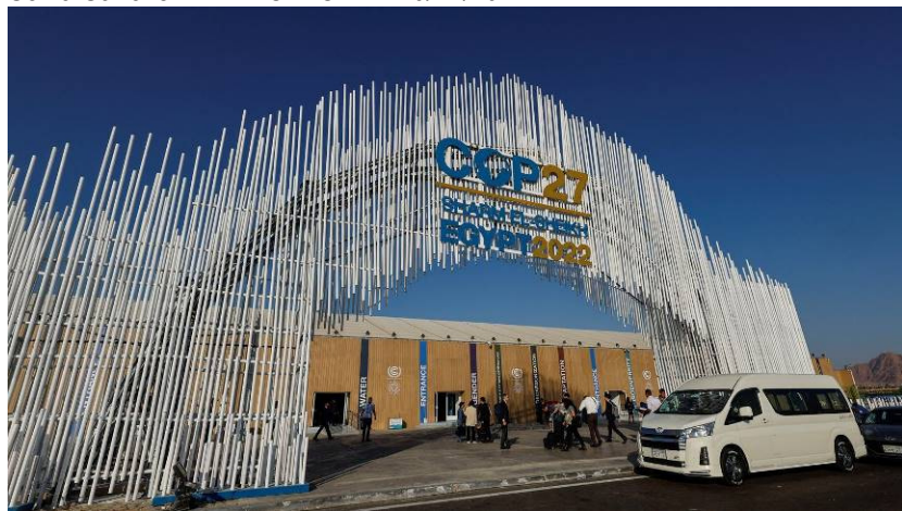
Vista del Centre de Convencions Internacional de Sharm El Sheikh abans de l'obertura de la cimera del clima de la COP27 a Sharm al-Sheikh, Egipte. MOHAMMED SALEM / REUTERS
