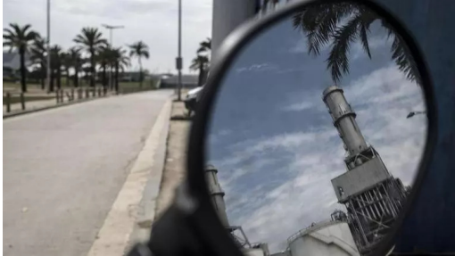
La xemeneia de la incineradora de residus TERSA a Sant Adrià de Besòs. XAVIER BERTRAL
