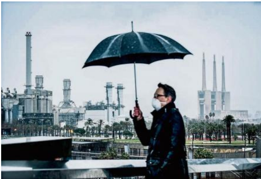
Incineradora de residus de Sant Adrià de Besòs, a l'esquerra. Xavier Cervera
