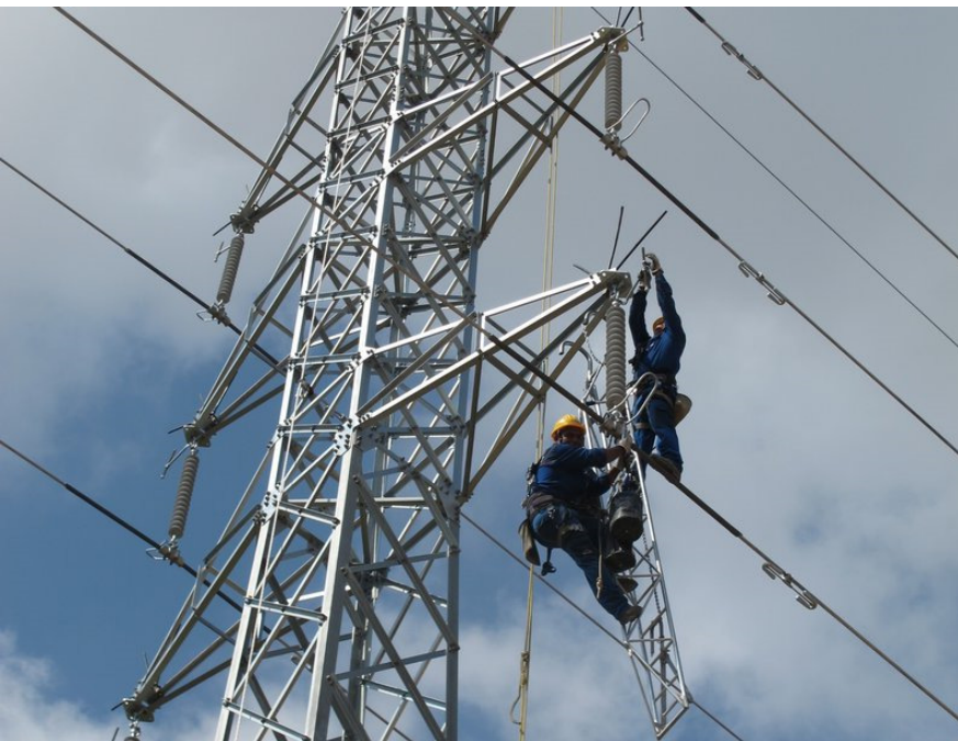
Dos operaris feinejant en una línia de molt alta tensió M.M.
