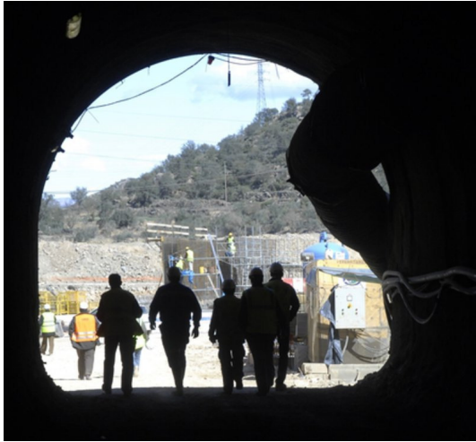
Excavació d'un túnel a Ponts de la xarxa del canal Segarra-Garrigues. EL PUNT.
