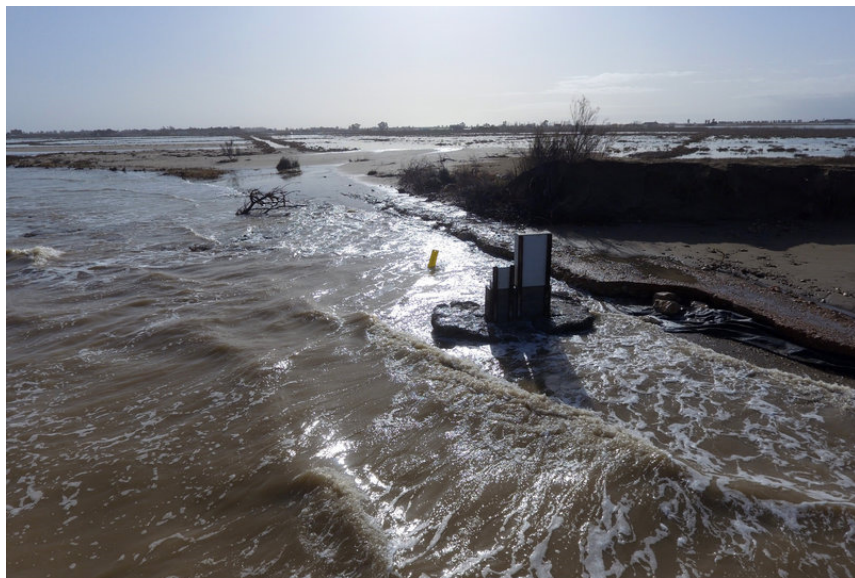
Mar trencant un dic de sorra i entrant als arrossars a la zona de la platja de la bassa de l'Arena, al delta de l'Ebre ACN
