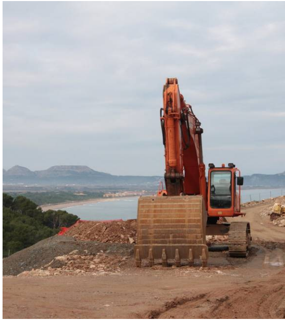
Obres en curs a la pedrera de s'Antiga, a Begur, amb la badia de Pals al fons Arxiu.
