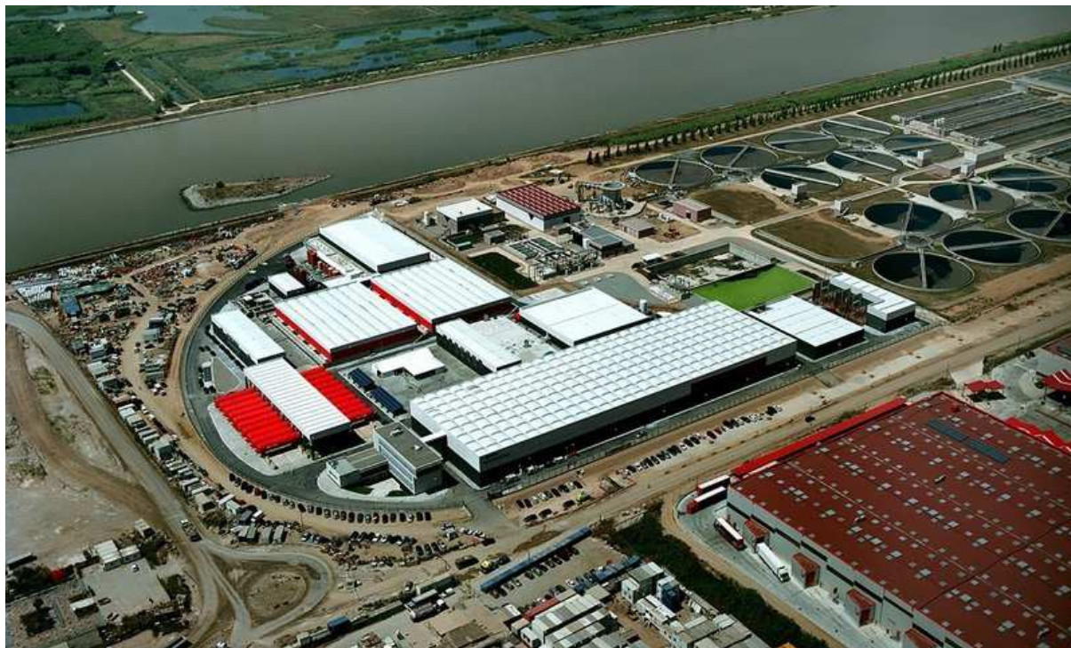
Vista aèria de la planta dessalinitzadora del Prat, fora de servei per una avaria. Foto: ARXIU.
