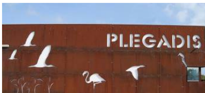
Façana de la Fundació Plegadis.
