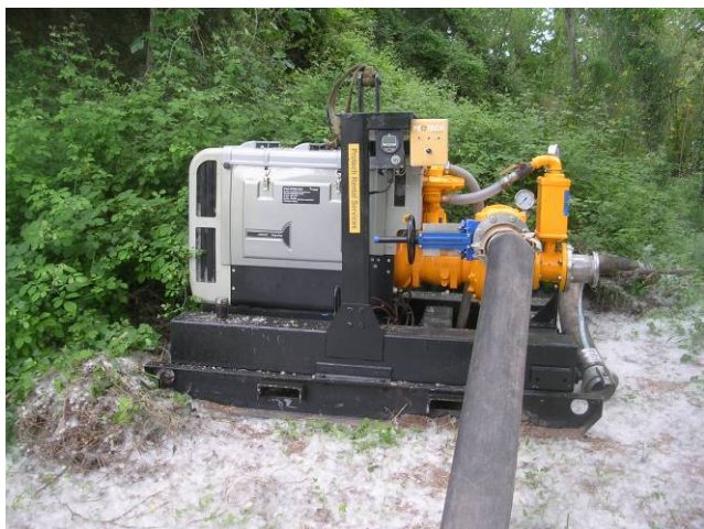
A l'esquerra, bomba utilitzada durant l'obra per evitar el vessament d'aigües residuals.
