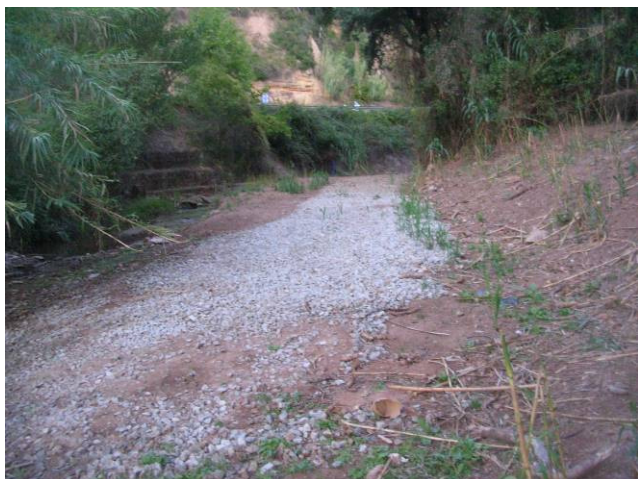
A l'esquerra, grava de granit escampada en gairebé tot el tram de riera afectat per les obres.
