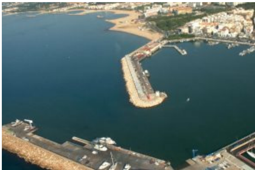
Figura 1B: Port i platges de Cambrils, a Tarragona. La construcció de ports i espigons incrementa el volum d'aigües confinades, que són un hàbitat idoni per a les proliferacions de dinoflagel·lades. / Foto: Jordi Camp
