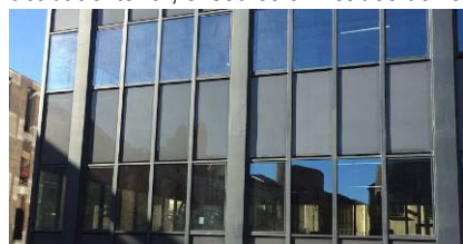
El tancament gris de la façana és un vidre fotovoltaic i fa de tancament opac de l'ampit de les finestres transparents / Foto: Trama Tecnoambiental
